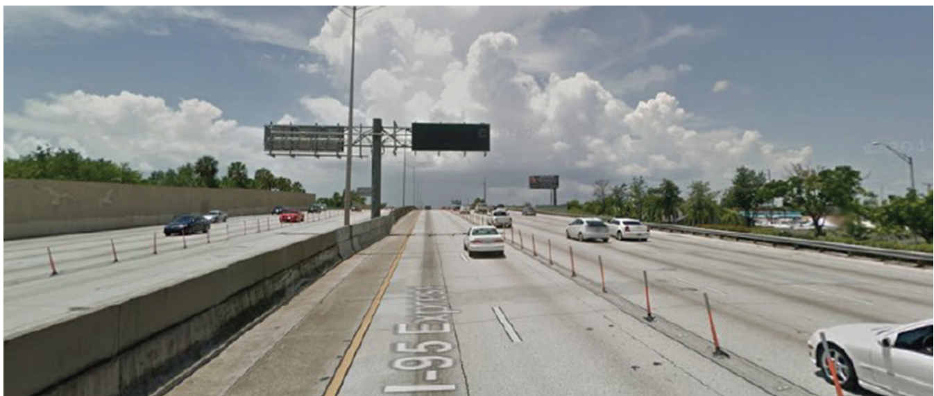
Figure 9. Photo. I-95 Express Lanes in Miami-Dade, Florida.
